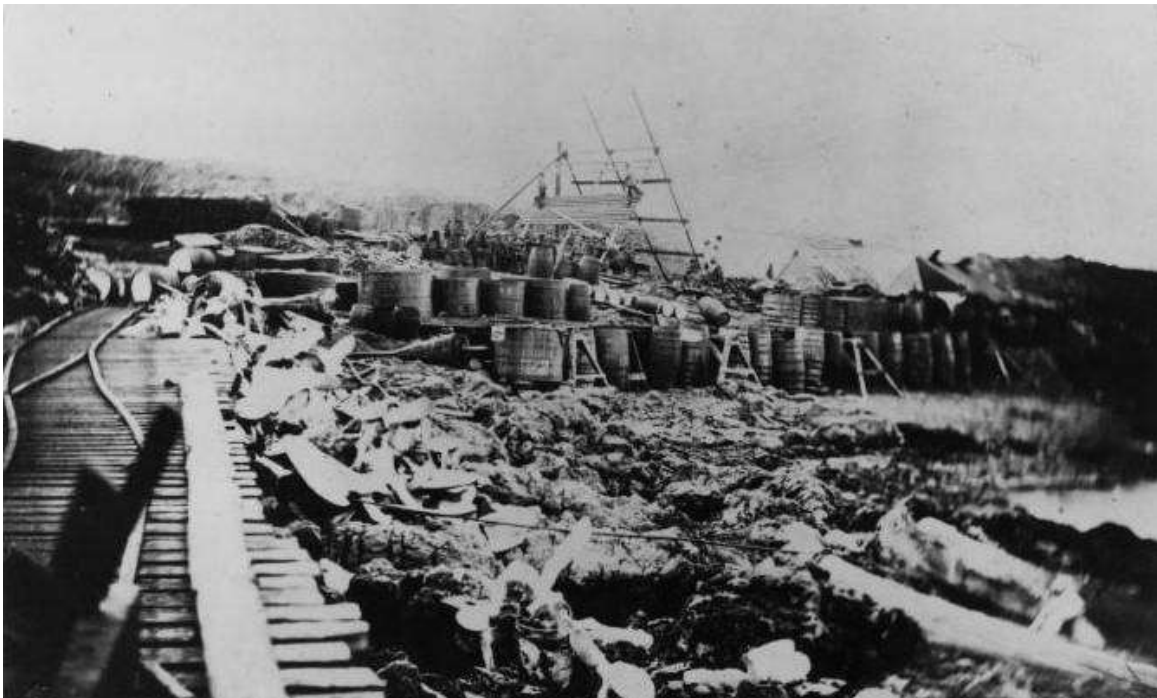
Athafnasvæði Hammers og Danska fiskveiðifélagsins (Det danske Fiskeriselskabs Etablissement) undir Bóndavörðuhrauni sumarið 1867. Eftir bryggjunni liggur teinabraut á sliskjum og á fjörukambinum er fjöldi keralda og tunna. Fyrir miðri mynd eru margir menn að störfum og við húsbýggingu, að því er best verður ráðið. Er því hugsanlegt, að þá hafi staðið yfir bygging lýsisbræðsluhússins, sem kallað var Smeltiríið. Til hægri við timburgálgann eru tjöld og hús með mænispaki, trúlega það hús eða skúr, sem lengi stóð lítið eitt neðan við suðvesturhorn bræðsluhússins. (Ljós. Johan Holm-Hansen. Þjms. Lpr-4853.)
