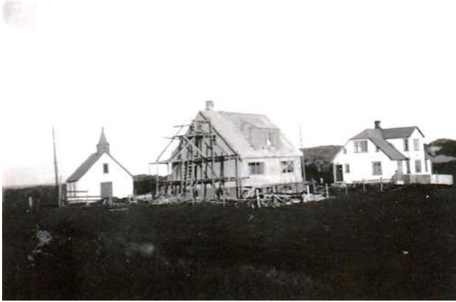
Djúpavogskirkja, Dalir og Prestshúsið í byggingu árið 1950. Yfirsímiður þess var Einar Sigurðsson, tré- og skipasímiður í Odda á Fáskrúðsfirði. (Myndasafn Rafns Kjartanssonar.)
