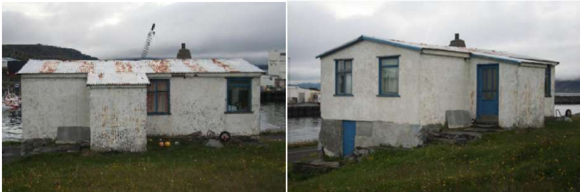
Austurhlið og suðurgafl Sólvangs 2013. (Ljós. Páll Jakob Línal.)
