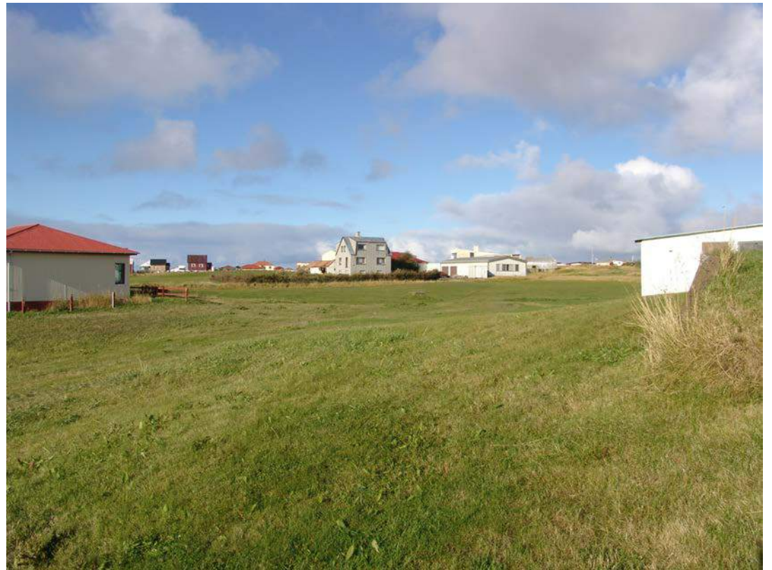
Víkurbraut 13 til vinstri og húsaþyrpingin fyrir miðju tilheyrir Víkurbraut og Norðurgötu. Til hægri sést í Krókskot.
