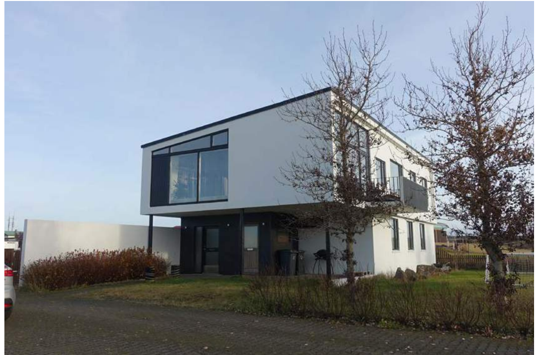
Austurgata 11, byggt 1960. Húsið er gott dæmi um módernisma í íslenskrri byggingarlist. Það stendur á hornlóð og er mikilvægt fyrir götummyndina.
