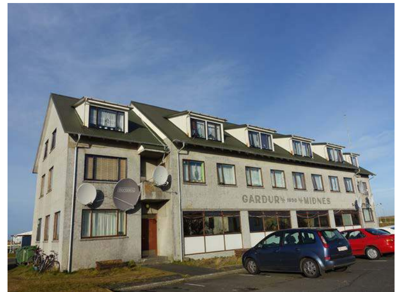
Tjarnargata 1-3, "Miðnes", byggt 1953. Byggingin hefur varðveislugildi út frá atvinnusögu og er mikilvægur hluti af götummyndinni.
