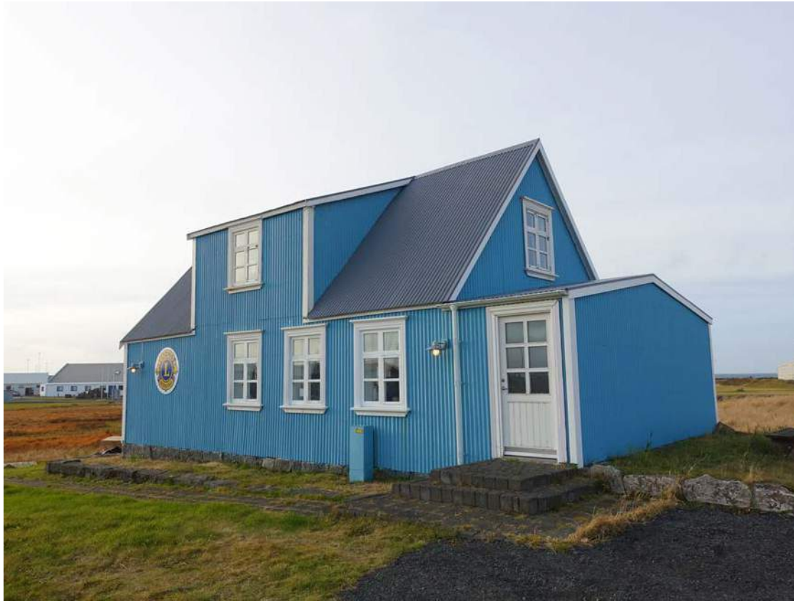
Tjarnargata 7, "Efra-Sandgerði", byggt 1883. Húsið er elsta hús Sandgerðis og það stendur fallega í náttúrunni við Sandgerðistjörn. Húsið er friðað og hefur mikið varðveislugildi vegna menningarsögu, byggingarlistar og umhverfis.
