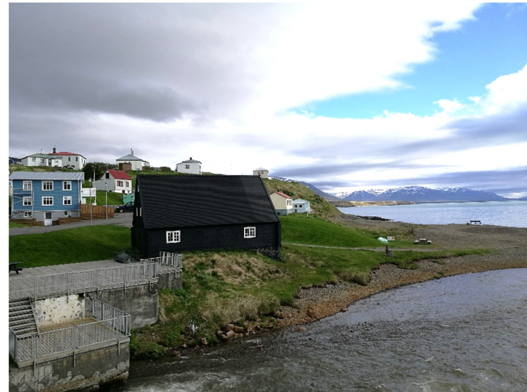
Mynd 34. Steypt mannvirki við Pakkhús. GZ, 2018.
