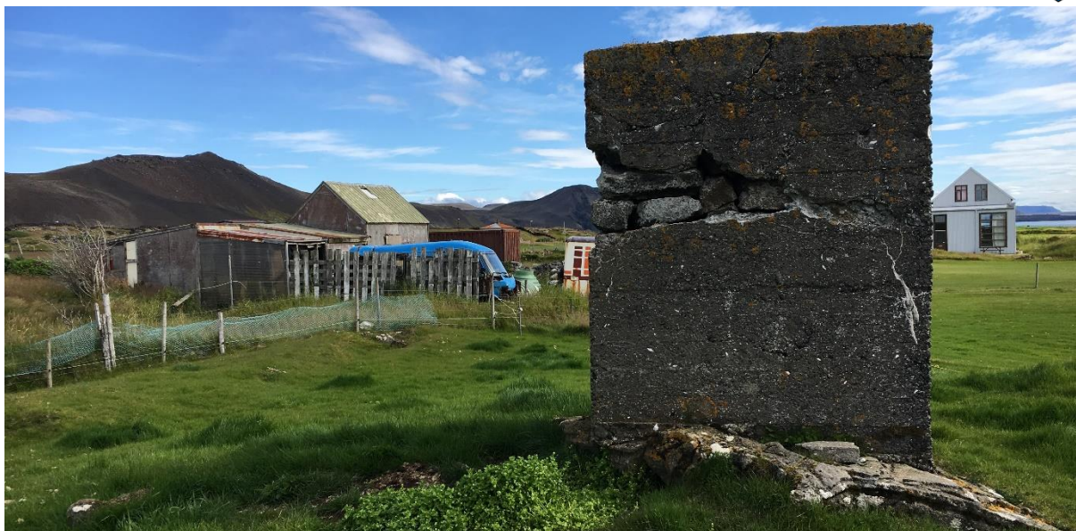
Mynd 10. Steyptur stöpull undan einni af vindmyllum hverfisins. Mynd: Fornleifastofnun Íslands.
