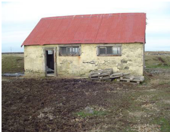
Úr fornleifaskýrslu FS367-07221 frá árinu 2008. Eitt af eldri steinhúsum sem gengur undir nafninu Lýsisbræðslan, sennilega byggt fyrir 1919.
