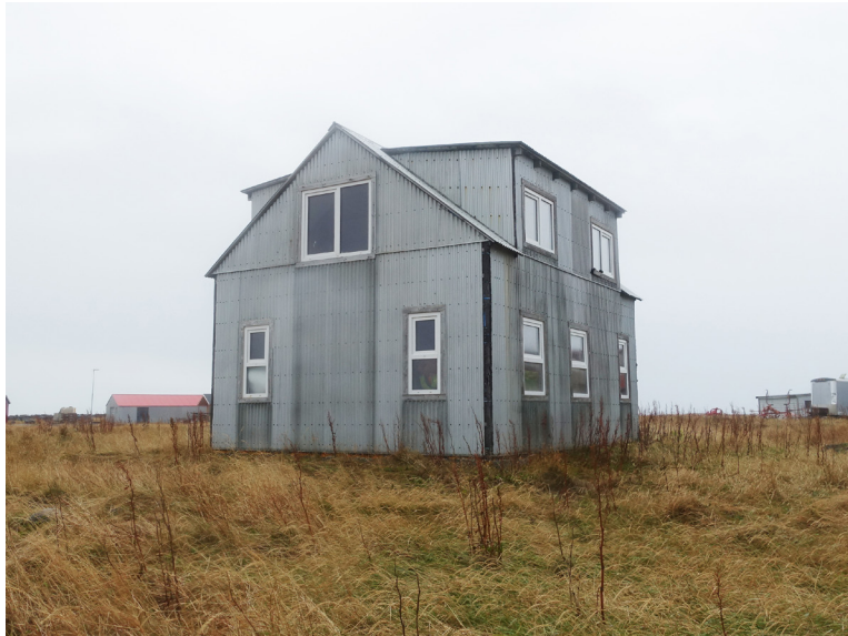
Akurhús 1, timburhús byggt 1912.
