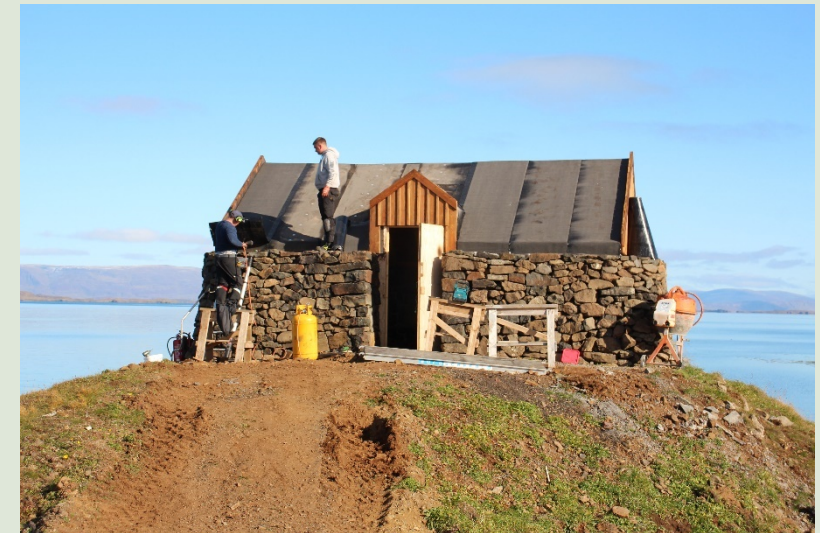
Mynd 24: Vinna við gerð tilgátuhússins í landi Þingvalla, Helgafellssveit.
