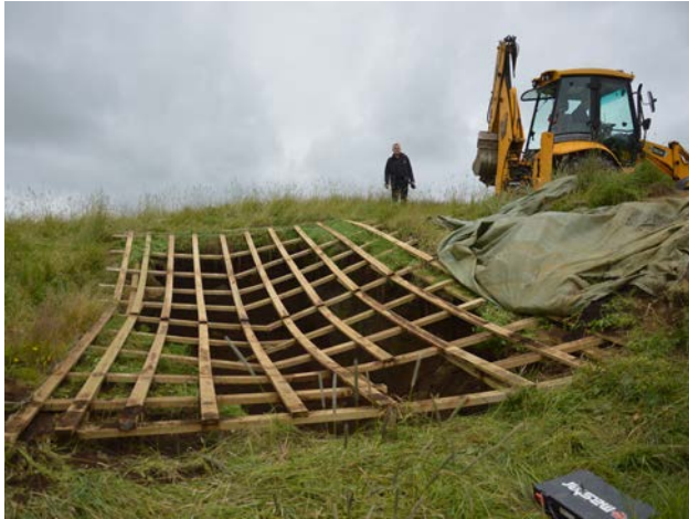
Mynd 9. Svæði 1 opnað með því að fjarlægja dúk og timburgrind sem lokuðu því.
