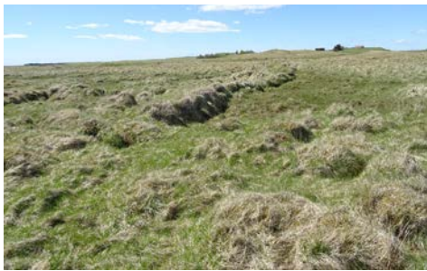
Upphlaðin torfbrú 03 á leið 038, horft til suðvesturs.
