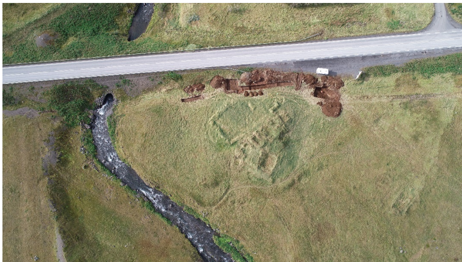
Mynd 9. Yfirlitsmynd af framkvæmdasvæðinu við Ártún Kjalarnesi. Ljósmynd: Stefán Hjalti Garðarsson.
