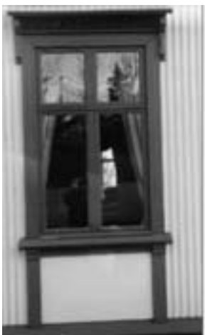
Ráðherrabústaðurinn, Tjarnargötu 32, Reykjavík, byggt 1907, endurbyggt 1994, arkitekt Húsameistari ríkisins.
