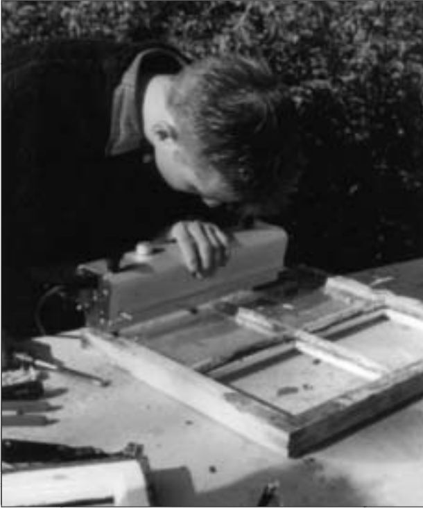
Gamalt og hart kitti verður mjúkt eftir 20-30 sekúndur undir kittislampanum.
