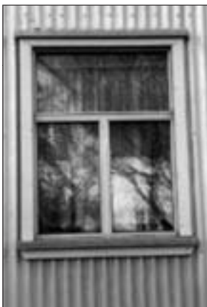
T-póstgluggi þar sem rammarnir hafa verið teknir úr og einangrunargler sett beint í karminn með glerlista.
