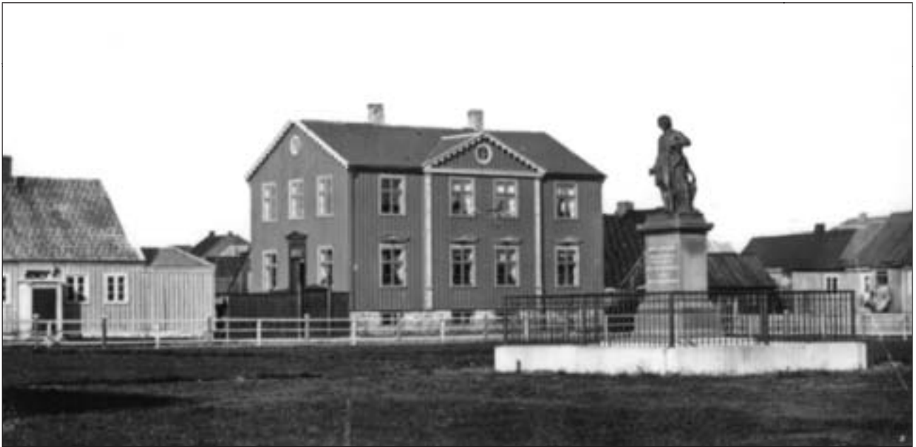
Kvennaskólinn, nú mötuneyti Pósts og síma, Thorvaldsensstræti 2 (við Austurvöll), Reykjavík. Myndin er frá því um síðustu aldamót. Byggt 1878 af Helga Helgasyni trésmiði.
