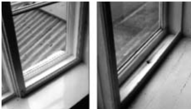
Krosspóstgluggi með upprunalegum viðbótarramma. Laufásvegur 34, Reykjavík, byggt 1909, forsmiður Einar Pálsson?
