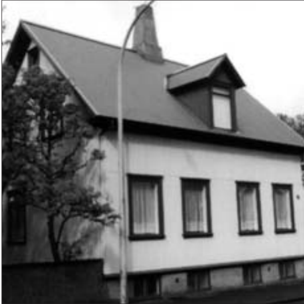
„Augnstungið“ hús, rammar og póstar hafa verið fjarlægðir.
