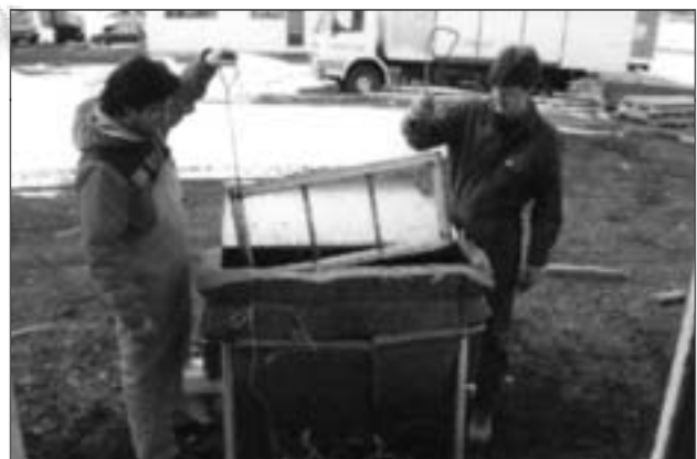
Í línólíusúðkerinu eru rammarnir olíubornir og málning fjarlægð um leið.
