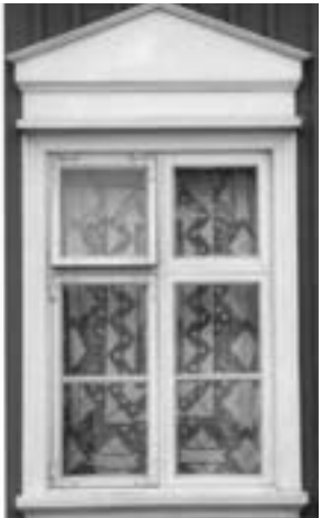
Vesturgata 27, Reykjavík, byggt 1881, endurbyggt 1981, arkitektar Magnús Skúlason og Sigurður Harðarson.
